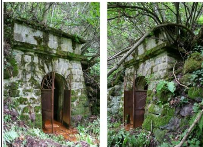
TAUL MARE – intrare, acces către tunelul de evacuare a apei
